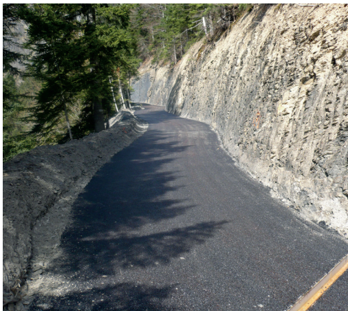
Aménagement de la route forestière de la Trappe à Passy en 2014/2015
