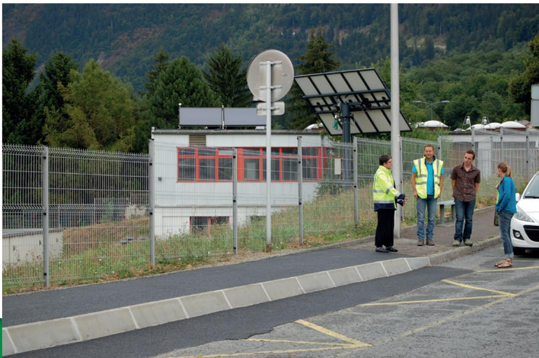
*Le trottoir a été surelevé afin de permettre l'emploi plus aisé d'un plan incliné pour débarquer et embarquer les personnes à modilité réduite à bord des bus.*
